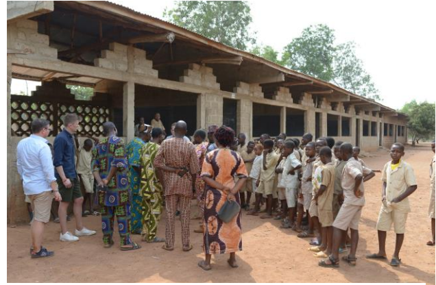
halbfertige Klassen in Lissazounmé
