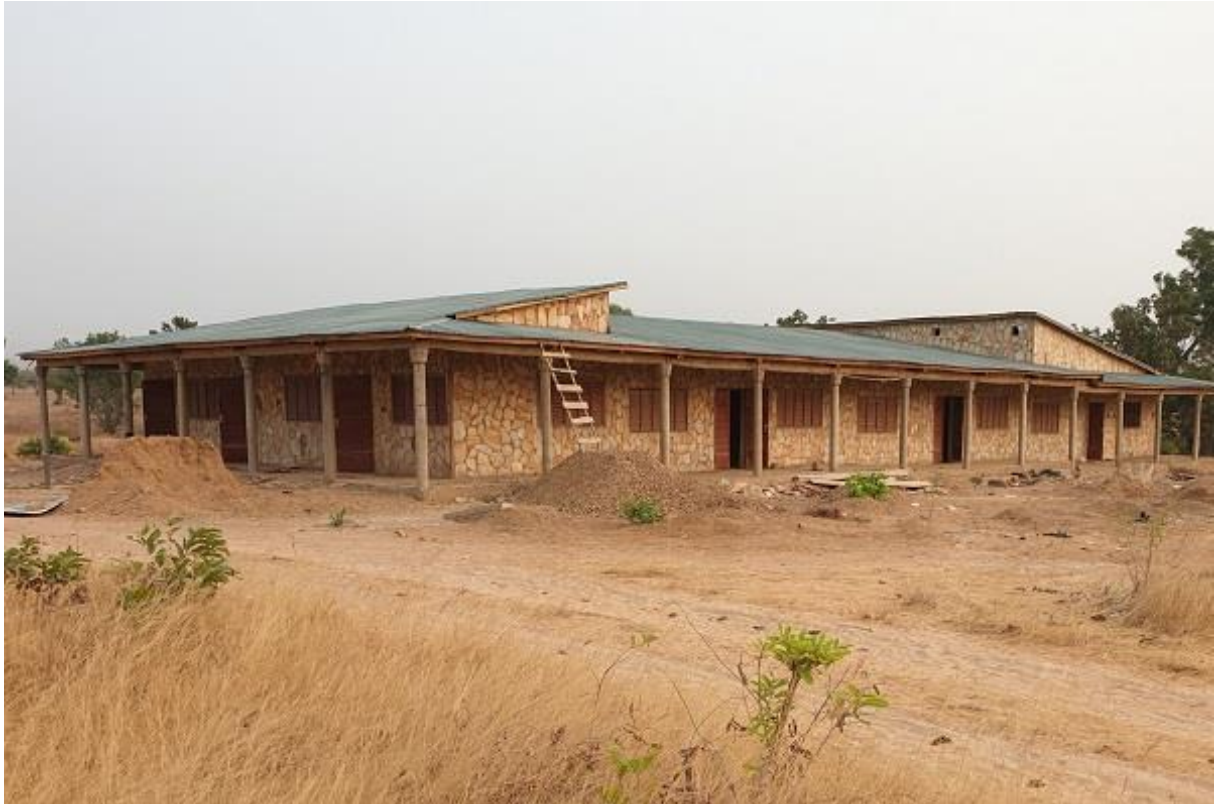
Der Bau der Krankenstation geht zügig voran
